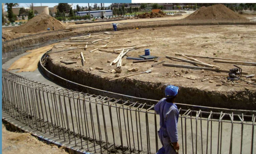
◀ اجرای آرماتور و قالب بندی فونداسیون مخازن
