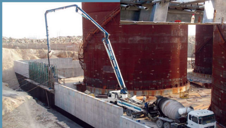
▶ اجرای Dike Wall مخازن
