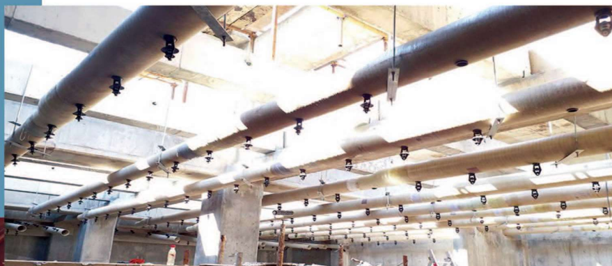
◀ نصب تأسیسات کولینگ تاور
